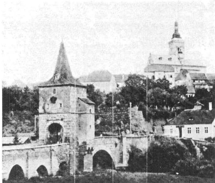
Obr. 18 – Most ve Stříbře ze 16. století. Snímek byl pořízen na počátku tohoto století
